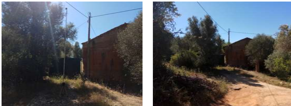
Figura 4.7.4 - Apontamento fotográfico do Ponto 3
